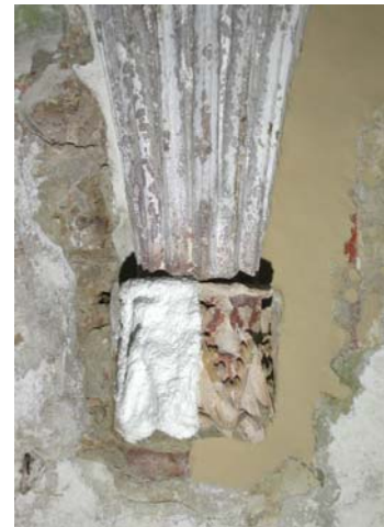
Langhaus/ Südwand, Wandbereich zwischen dem 1. und 2. Joch. Links: Zustand der Wandfläche 2006. Rechts: Zustand der Wandflächen 2007 nach der Konservierung im westlichen Bereich (rechts).
