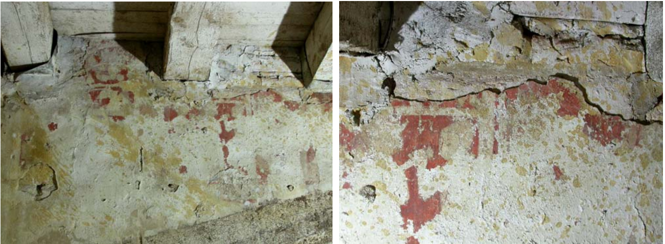
Langhaus/ Nordwand, westliches Joch, Wandbereich unterhalb der eingezogenen Zwischendecke. Links: Zustand eines gut erhaltenen Malereifragmentes des Heilsspiegelzyklus 2007. Rechts: Detailaufnahme. Zu sehen sind stark ablösende Randbereiche. Dieser Malereibereich ist substanziiell gefährdet, da der Putz teilweise keinen Kontakt zum Mauerwerk aufweist.
