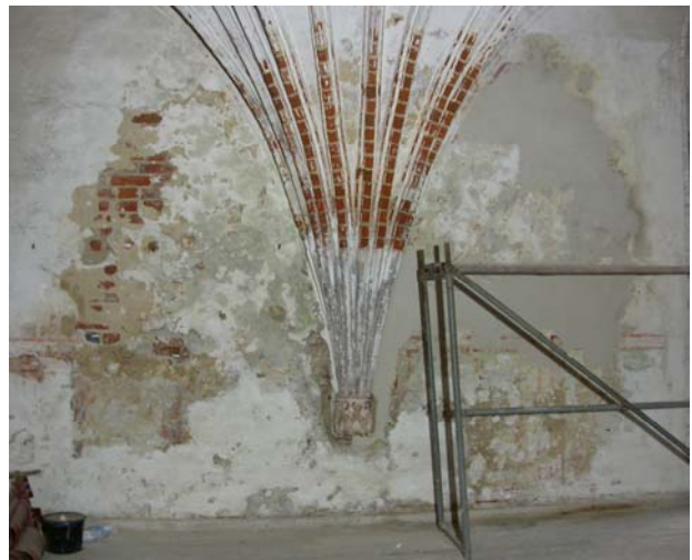
Langhaus/ Südwand, Wandbereich zwischen dem 1. und 2. Joch. Links: Zustand der Wandfläche 2006. Rechts: Zustand der Wandflächen 2007 nach der Konservierung im westlichen Bereich (rechts).
